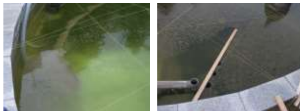
図-3 攪拌直後の汚泥浮上の様子と、オーバーフローによる汚泥除去
